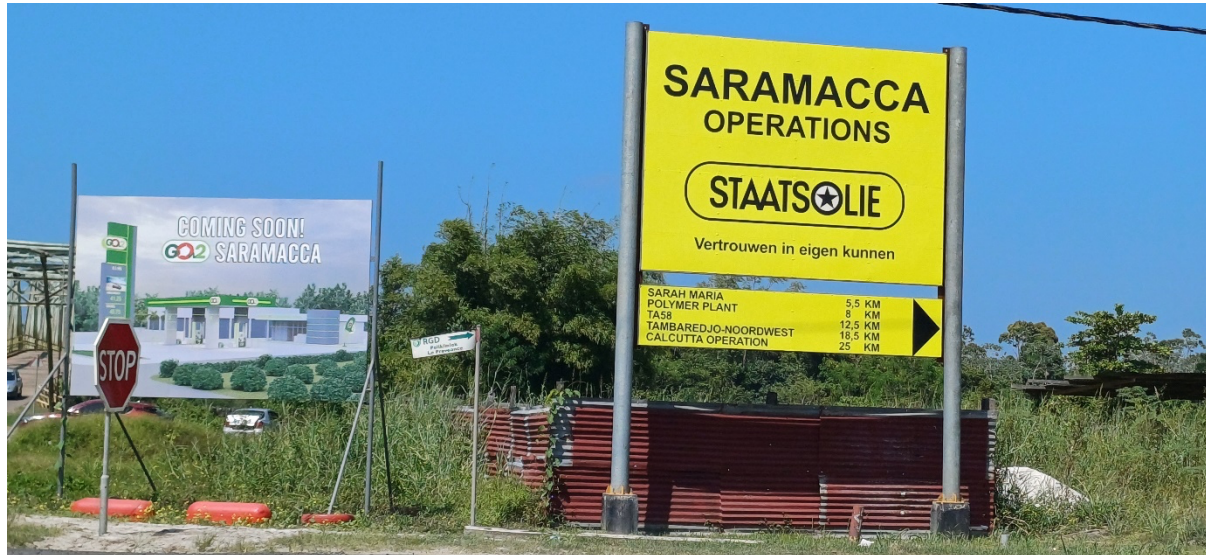
Foto 5: Locatie en billboard bouw GOw2 pompstation
