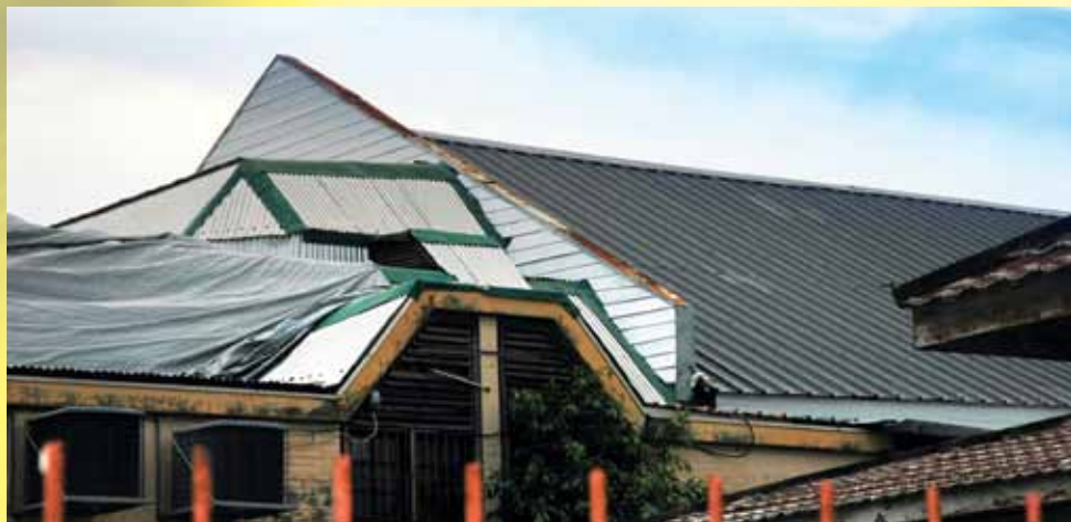
Kunst en Cultuur: vervanging asbestdakbedekking van schouwburg Thalia
